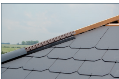
Velikost výstupního otvoru při větrání hřebenem je 100 \text{ cm}^2/\text{bm} . Větrací mezera 1 \text{ cm/bm} .
