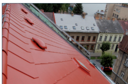
Větrání střešního pláště je realizováno plastovými hlavicemi.
